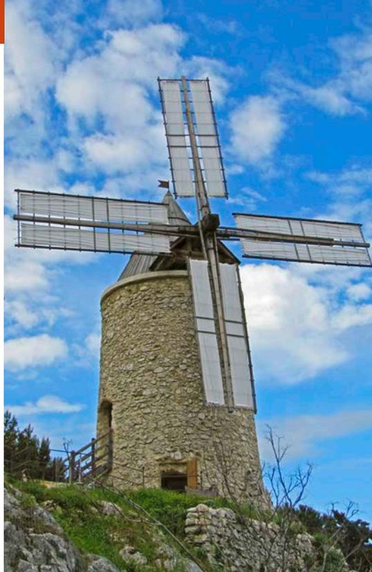
entraînées par le vent, actionnent la lanterne et le gros fer qui transmettent leur mouvement à la meule tournante. Le blé, versé dans la trémie, est alors écrasé entre la meule dormante (fixe) et la meule tournante. La farine est récupérée au rez-chaussée dans une huche en bois.
